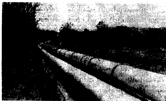
Hình 7.14. Đường ống thép đường kính lớn dùng để vận chuyển nước uống
