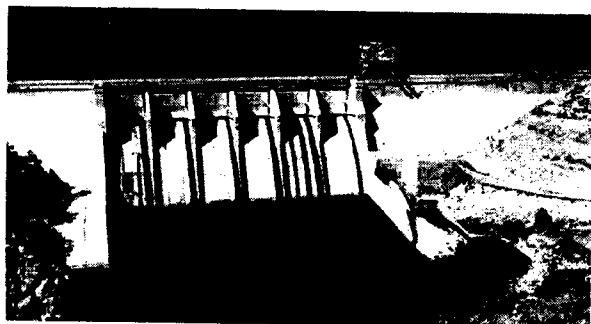
Hình 7.4. Đập bằng bê tông chảy theo lực trọng trường
