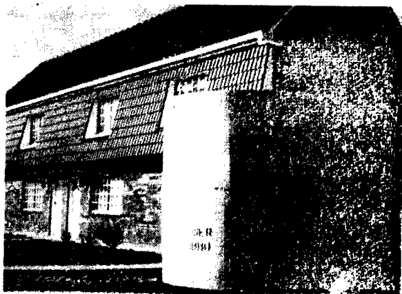
Hình 12.6. a) Bể bằng bê tông đúc sẵn lắp nổi trên mặt đất; b) Lắp hai nửa của bể bê tông đúc sẵn với nhau.
