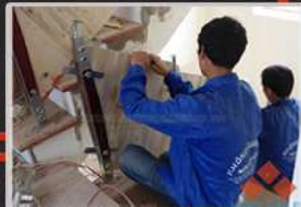
ĐỘI THI CÔNG CẦU THANG
