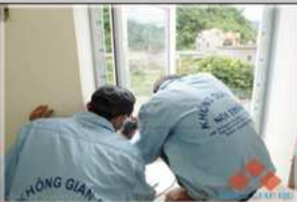
ĐỘI THI CÔNG CỬA PVC
